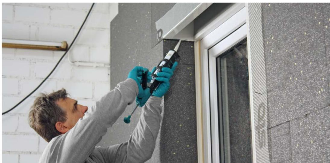
Hohe Klebekraft, einfache Handhabung: Der Kartuschenkleber StoSeal F 100 dichtet die Fugen in allen StoTherm-Systemen ab.
